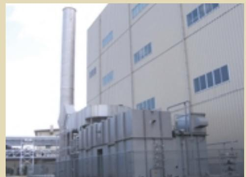
蓄熱式排ガス燃焼装置(福井村田製作所)
