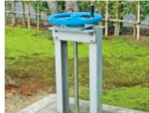
穴水電子工業の緊急遮断弁
