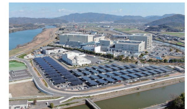
株式会社岡山村田製作所 駐車場型メガソーラーシステム
