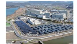
太陽光発電設備の導入による再生可能エネルギーの利用促進を図り、気候変動対策に向けた取り組みを進めるため、1,200台分の社有駐車場を活用し、日本最大級となる駐車場型メガソーラーシステムを導入
